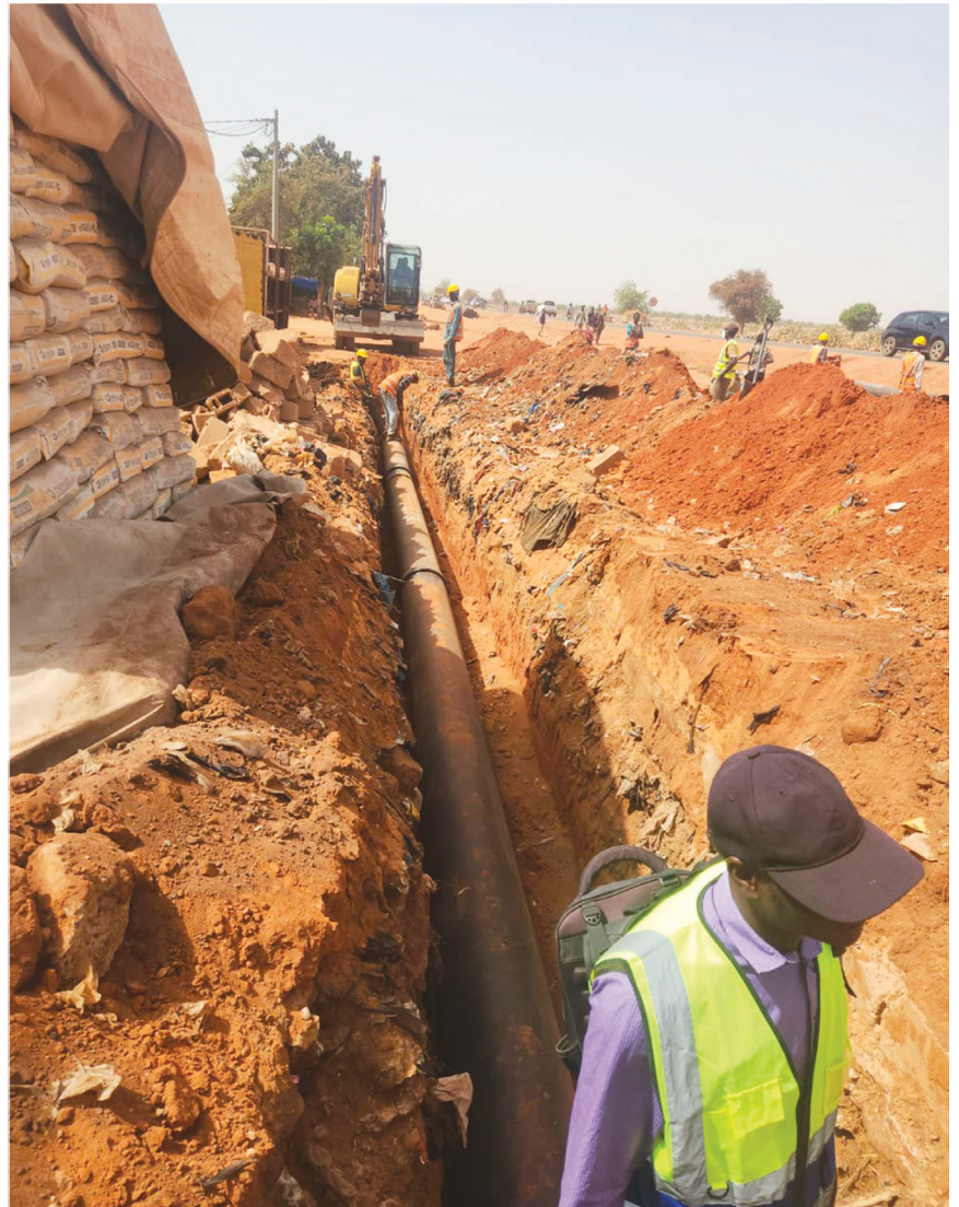
Un chantier de pose de conduites d'eau à la rive gauche
