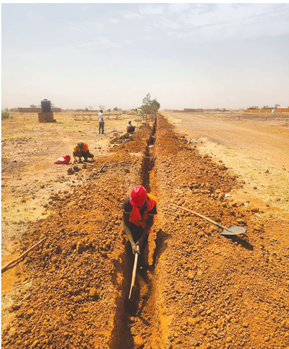
Sur un chantier de pose de conduites d'eau à la rive droite
