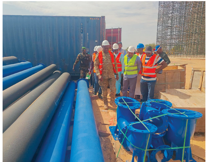
Le Ministre et sa délégation sur le site de construction du château
