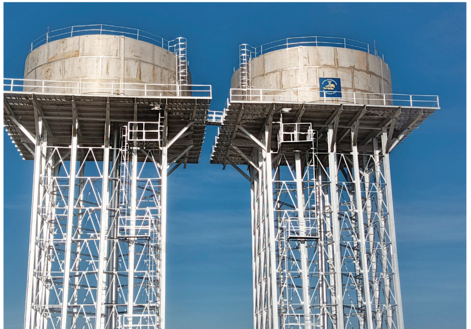
Une vue de deux châteaux d'eau de la ville de N'Guigmi ville de Diffa.
