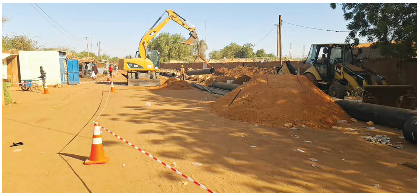
Une vue des travaux au quartier Aéroport de Niamey (Commune 4)
