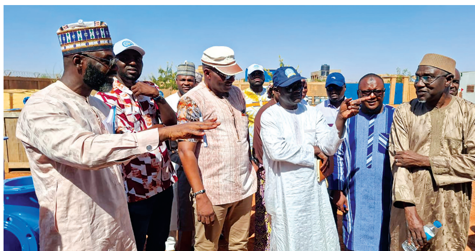
...au niveau de la base vie du groupement d'entreprises CHIALI/MTK services
