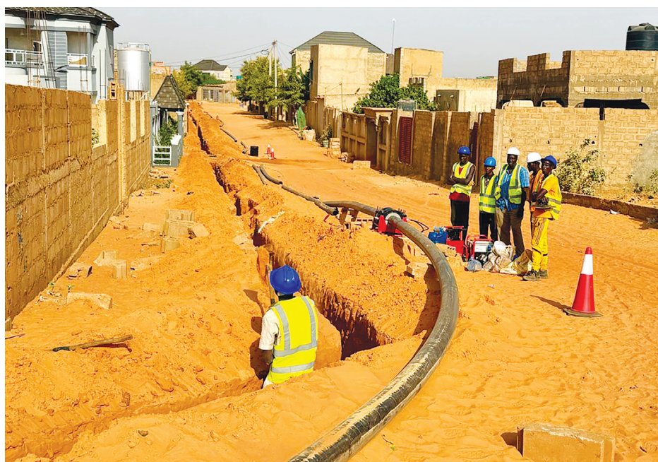
Les poses de conduite d'eau...
